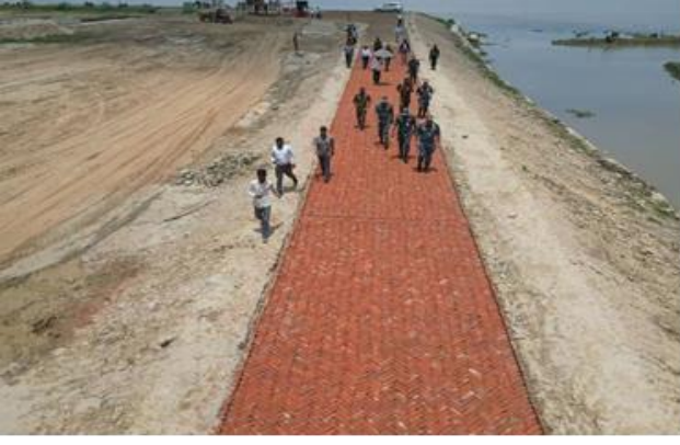
উপাচার্য মহোদয়ের প্রকল্প এলাকা ৬৪০ মিটার বাঁধের কাজ পরিদর্শন
