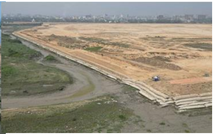
প্রকল্প এলাকার ৬৪০ মিটার বাঁধ নির্মাণে জিওটিউব স্থাপন সম্পন্ন
